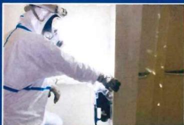
地震に備え、橋梁の耐性を向上させる「耐震補強」をはじめ、足場解体作業や効率的に作業を進行するための取り付け部材の搬入作業、そして、必要な箇所を削孔し、部材を確実に取り付けする削孔・取り付け作業を行っています。多種多様な作業を遂行し、橋梁の補強を確実かつ安全に実現しています。
