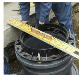
地下式消火栓設置の様子
