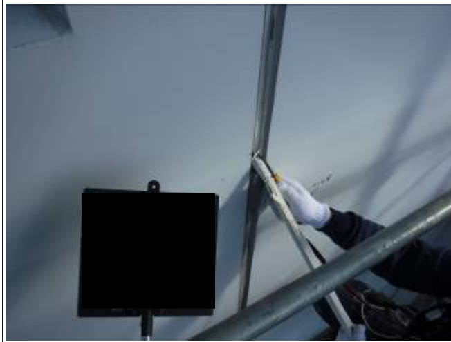
テナントビル大規模修繕工事 シール工事 外壁打継目地
