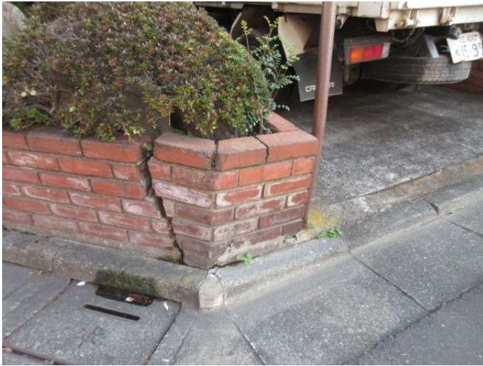
レンガ補修施工前
