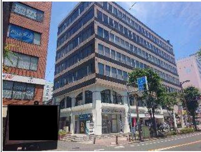
テナントビル大規模修繕工事
