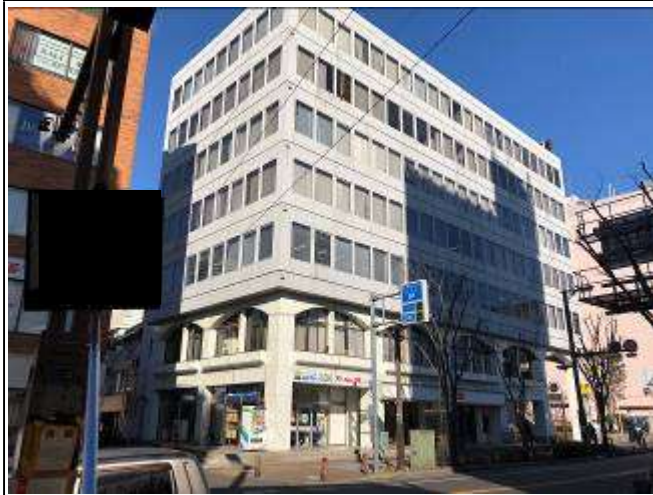
テナントビル大規模修繕工事
