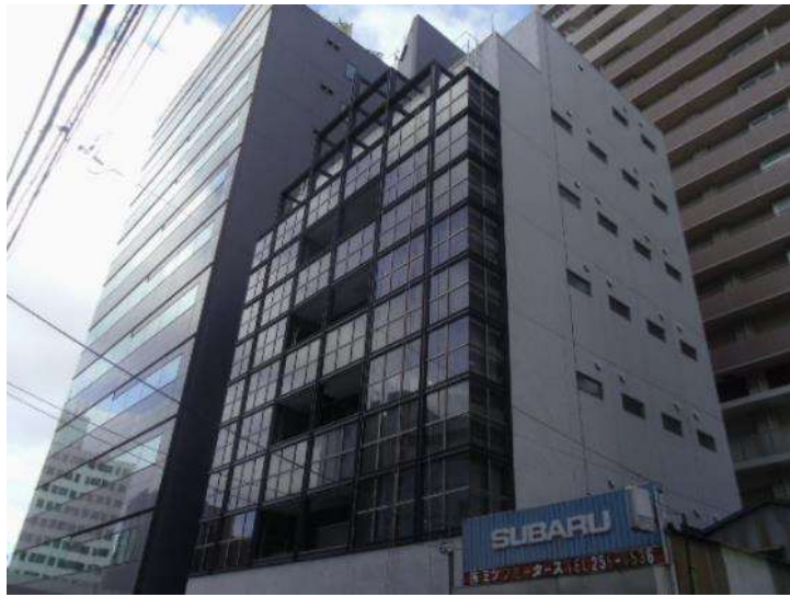
外壁サッシ取合漏水補修
