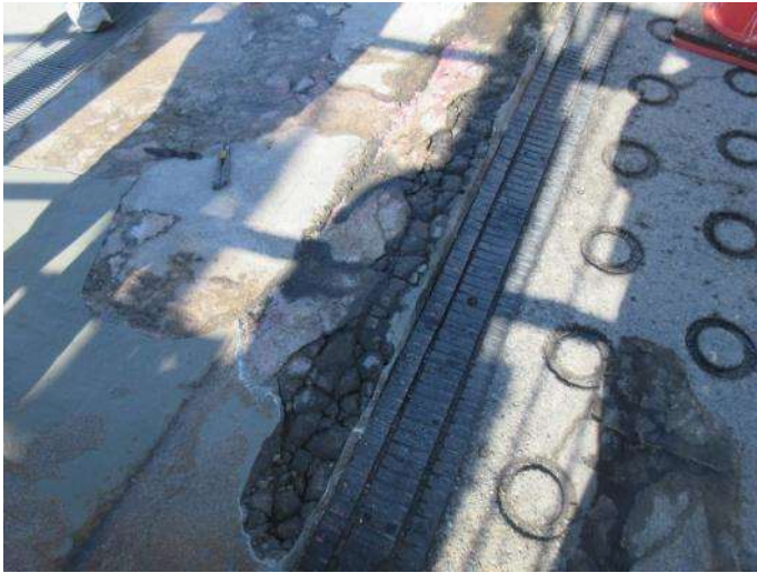
グレーチング端部破損部 施工完了
