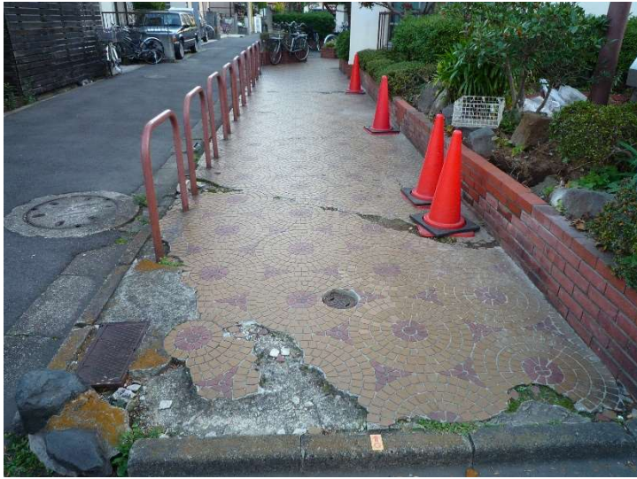
エントランス床改修
