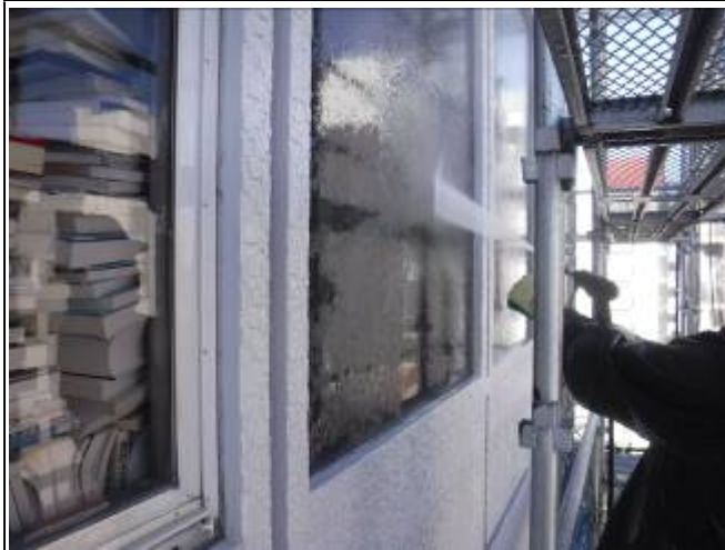
テナントビル大規模修繕工事 塗装工事 高压洗浄
