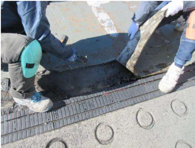
脆弱部撤去作業
