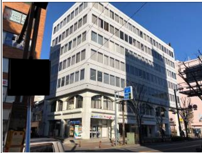
テナントビル大規模修繕工事 仮設足場
