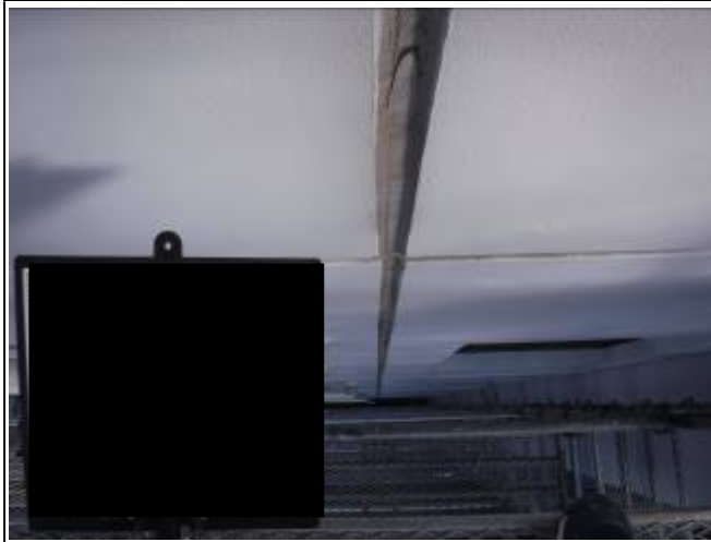
テナントビル大規模修繕工事 シール工事 外壁打継目地
