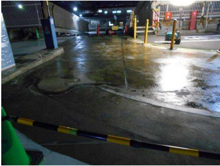
自走式駐車場床改修
