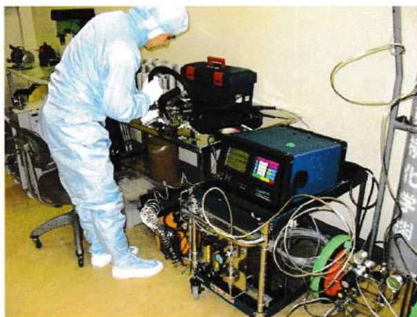
SWAGE LOK による自動溶接作業
