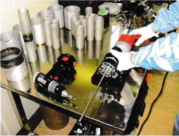
パイプ端面処理作業
